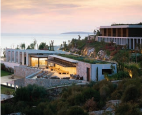
Six Senses Kaplankaya Oteli Bodrum - Muğla İç mekan ısıtma, 2400 m 2
