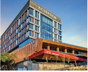
Acıbadem Hastaneleri Altunizade - Maslak - İstanbul Dış mekan buzlanma önleme, 2200 m 2
