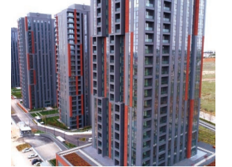
Bulvar Loft - Ankara Sprinkler Tracing, 900 m Dış mekan buzlanma önlem, 435 m 2
