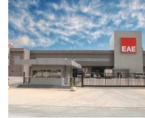
EAE Elektrik Fabrikaları - Dilovası - Kocaeli Fabrika çevresi, rampalar ve yükleme alanları kar buz eritme, 1183 m 2
