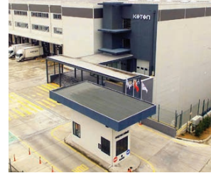
Koton Merkez Depo - Gebze -Kocaeli Çatı oluk donma/buzlanma önleme, 2303 m
