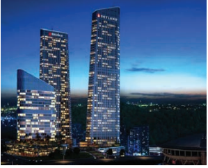
Skyland Eroğlu - İstanbul Kapalı yüzme havuzları çevresi elektrikli ısıtma, 305 m 2
