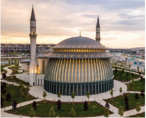
İstanbul Havalimanı Cami İç mekan ısıtma, 1400 m 2
