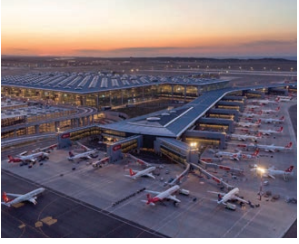
İstanbul Havalimanı Köprü Geçişleri Köprü geçişleri boru hatları tracing, 2500 m
